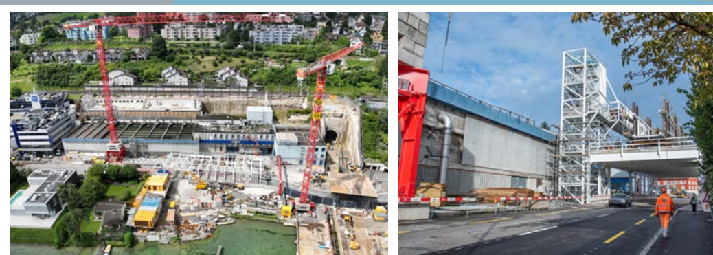
Rohbau der Betriebsräume und neue Membranbiologie (oben links).
