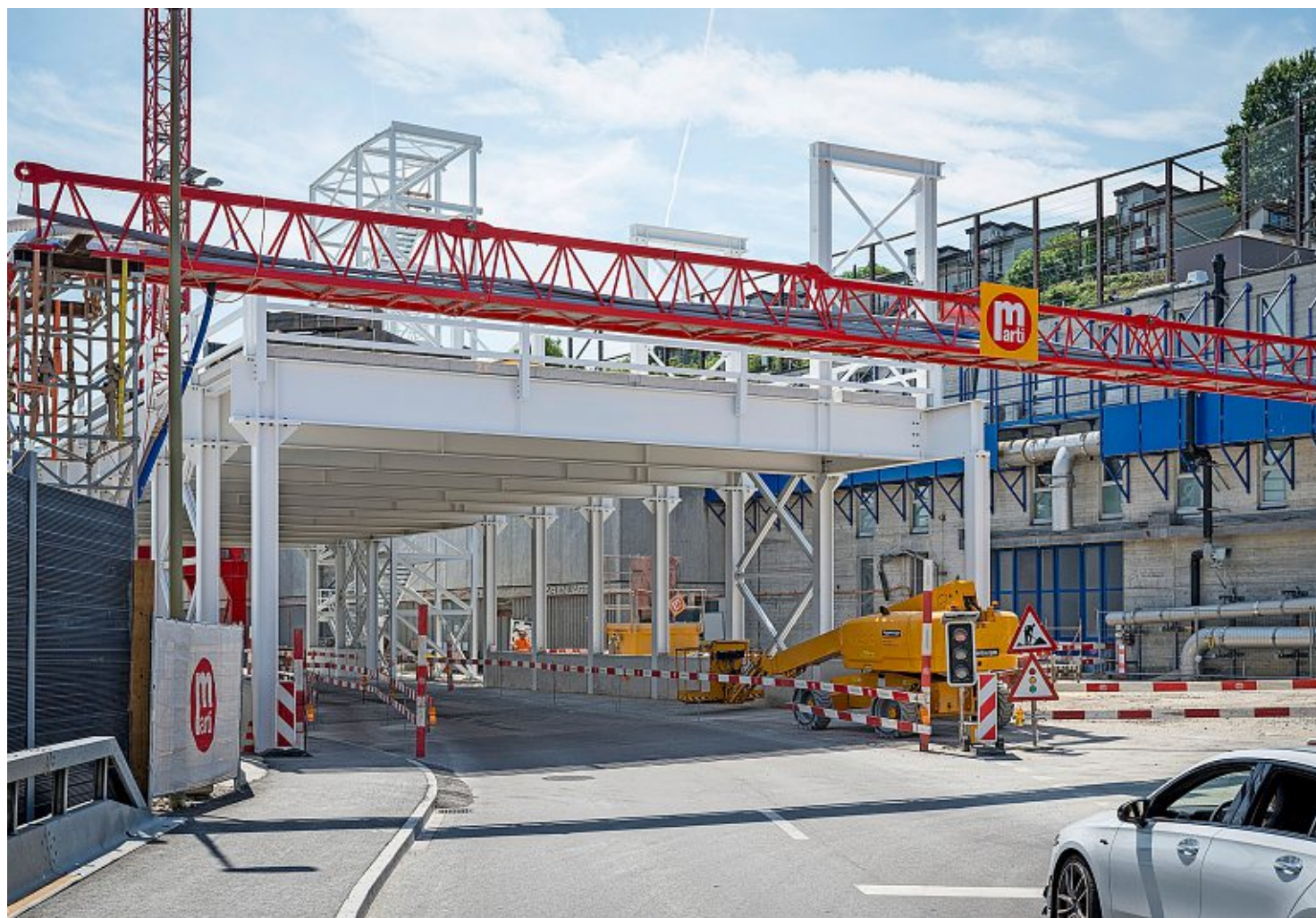
Die Plattform über der Seestrasse in Thalwil soll der Platzknappheit auf der Baustelle entgegenwirken. Foto: Michael Trost
