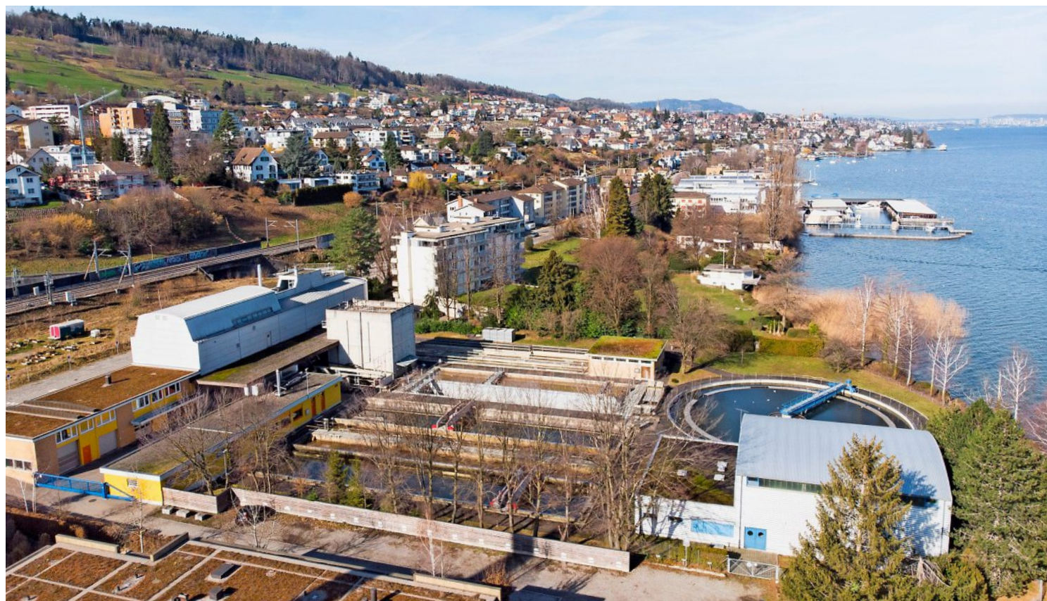
Mit dem Beitritt der Gemeinde zur ARA Zimmerberg würde die Kläranlage in Horgen nicht mehr gebraucht und könnte zurückgebaut werden. Damit stünde Horgen ein Stück Land an bester Lage zur Verfügung. Archivfoto: Moritz Hager
