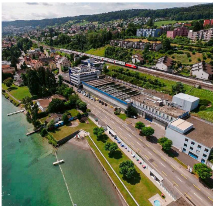
Luftaufnahme der bestehenden ARA Thalwil, die zur ARA Zimmerberg ausgebaut werden soll.
