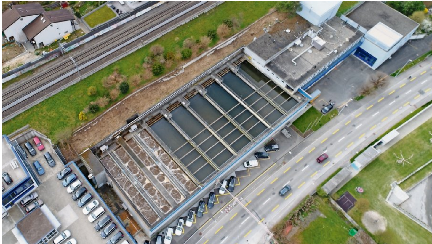
Die ARA Thalwil, gelegen zwischen Bahnlinie und Seestrasse, soll aufgestockt und überdacht werden.
