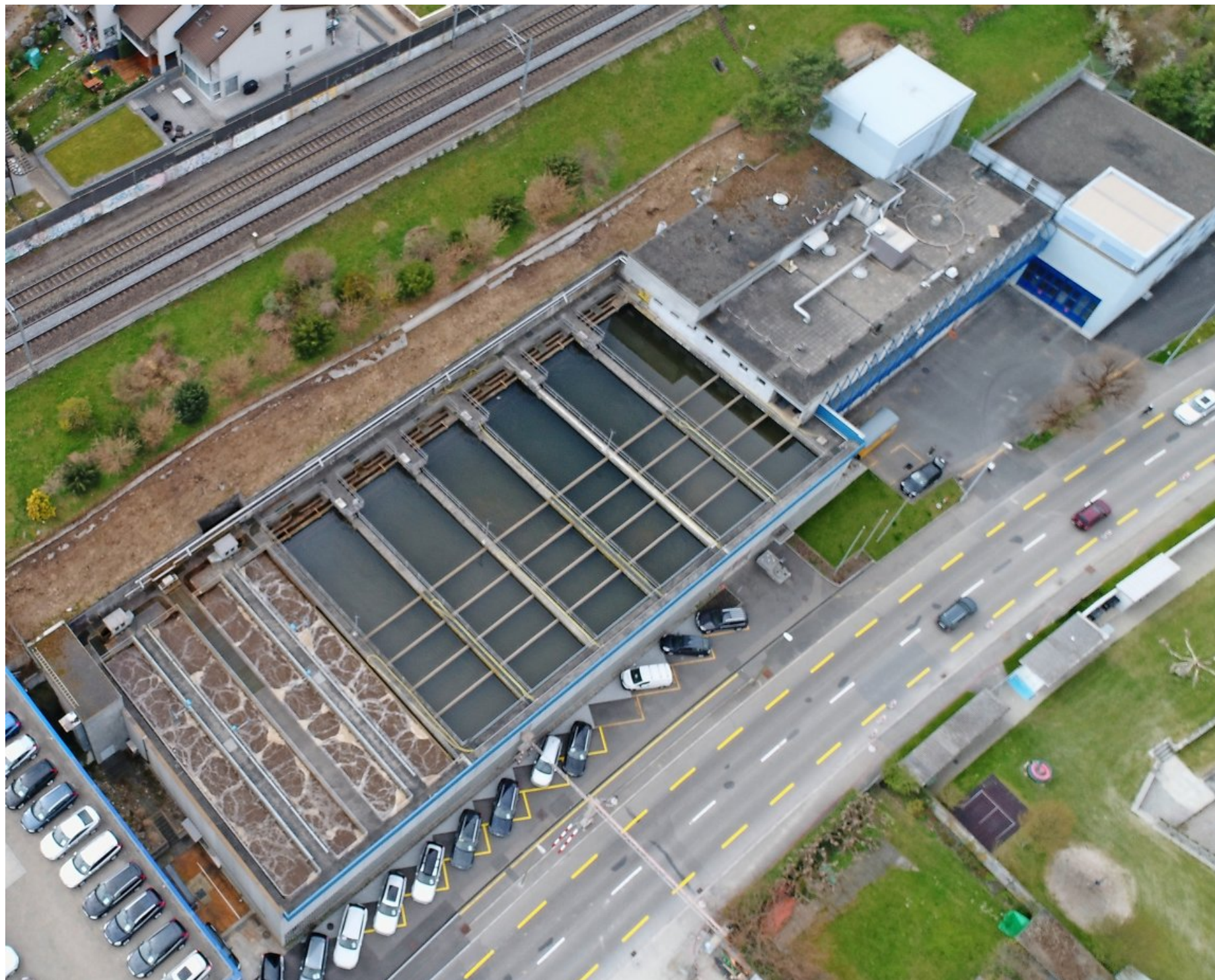
Die ARA Thalwil soll ab 2025 das Horgner Abwasser reinigen. Über den Projektierungskredit für die ausgebaut ARA Thalwil befindet Horgen am 7. Juni.
